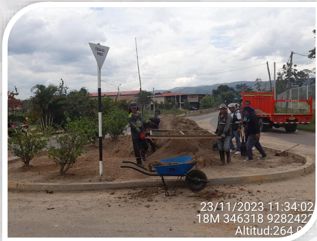
Mantenimiento de los Óvalos: Soldado, las Palmeras y Santa Anita
